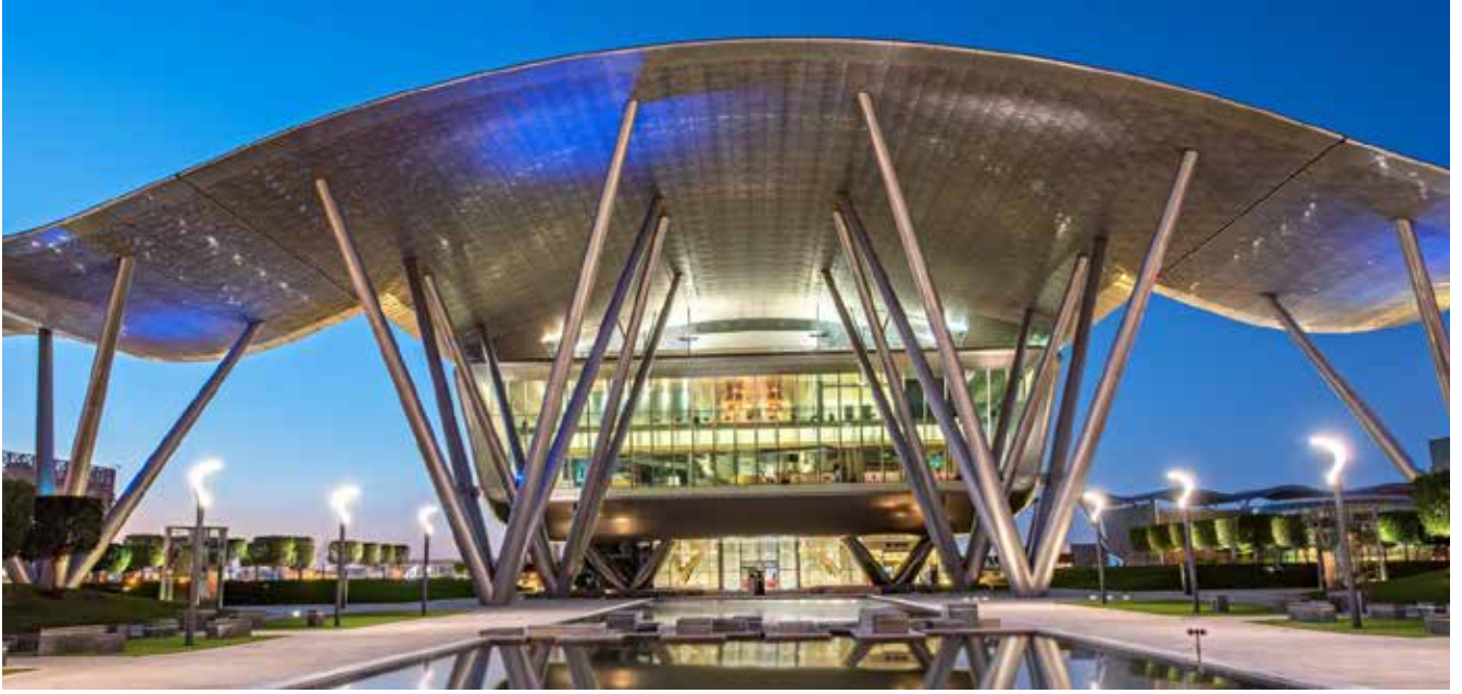
Katar MRO (Bakım, Onarım ve Modernizasyon) Merkezi
